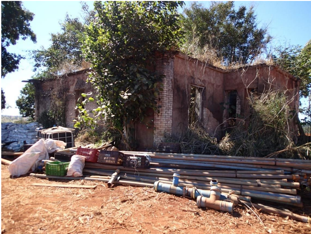
FIG. 107 VISTA DOS LADOS OESTE E SUL DA EDIFICAÇÃO (FOTO: RENATA ESTEVAM).
