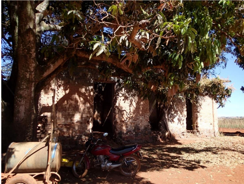
FIG. 106. VISTA DO LADO NORTE DA EDIFICAÇÃO (FOTO: RENATA ESTEVAM).
