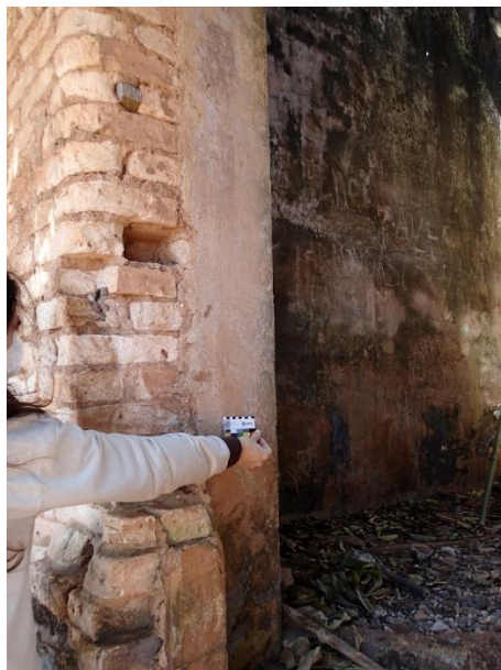
FIG. 108. ESPESSURA DAS PAREDES (FOTO: RENATA ESTEVAM).
