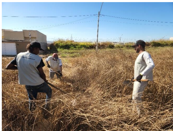
Figura 46. Limpeza da área para escavação. Fonte: Sapiens, 2022.
