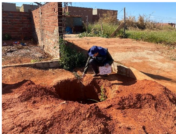
Figura 39. Vistoria de perfil exposto em fossa séptica nas proximidades do Sítio Inhumas. Fonte: Sapiens, 2022.
