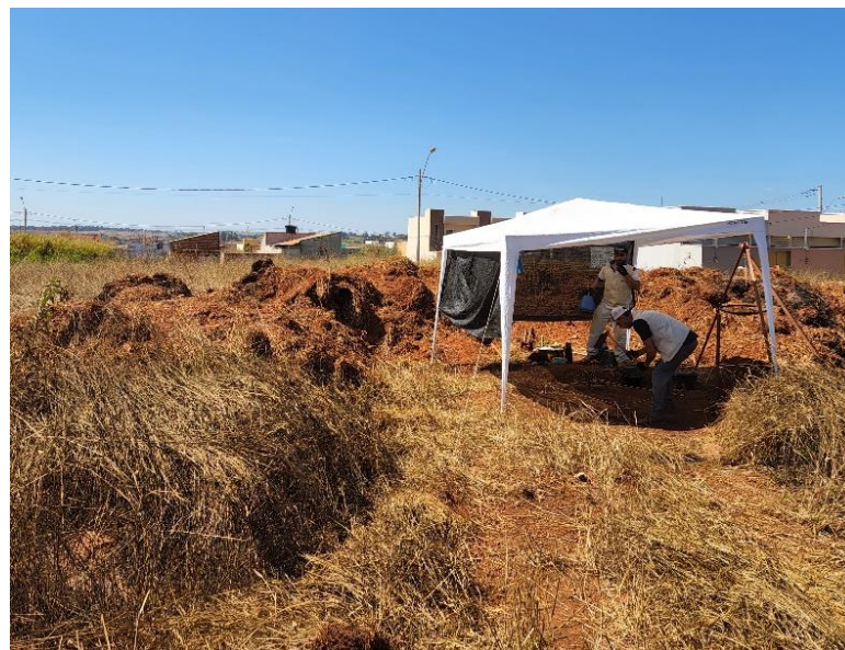
Figura 124. Setor 28, Destaca-se área destinada à escavação da unidade H2 e montículos de entulho ao fundo. Fonte: Sapiens, 2022.
