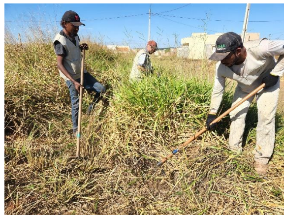
Figura 47. Limpeza da área para escavação. Fonte: Sapiens, 2022.
