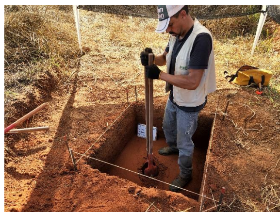
Figura 75. Processo de rebaixamento com trado manual. Fonte: Sapiens, 2022.
