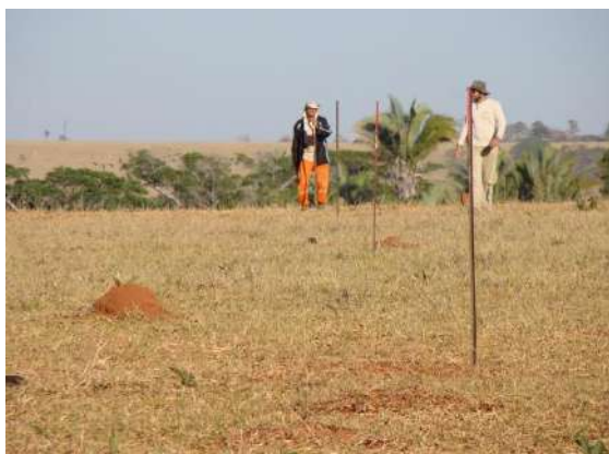
Foto 1: Marcação do alinhamento das sondagens
