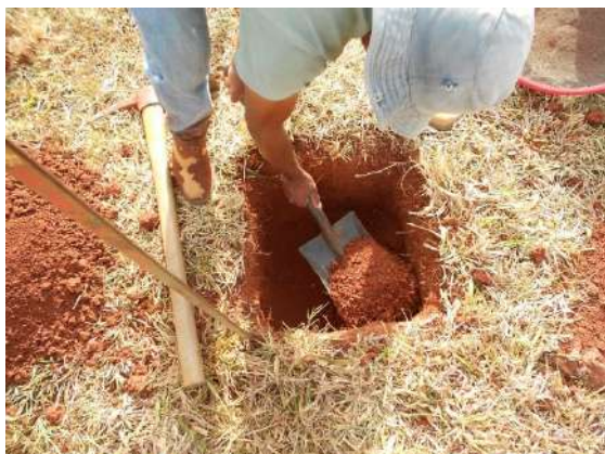
Foto 3: Escavação de sondagem
