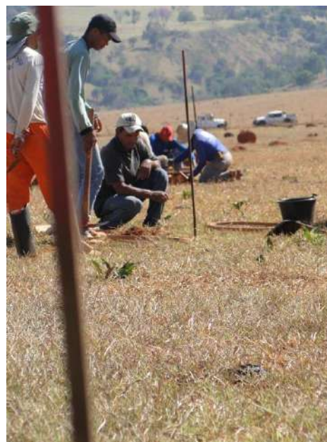
Foto 37: Escavação das sondagens
